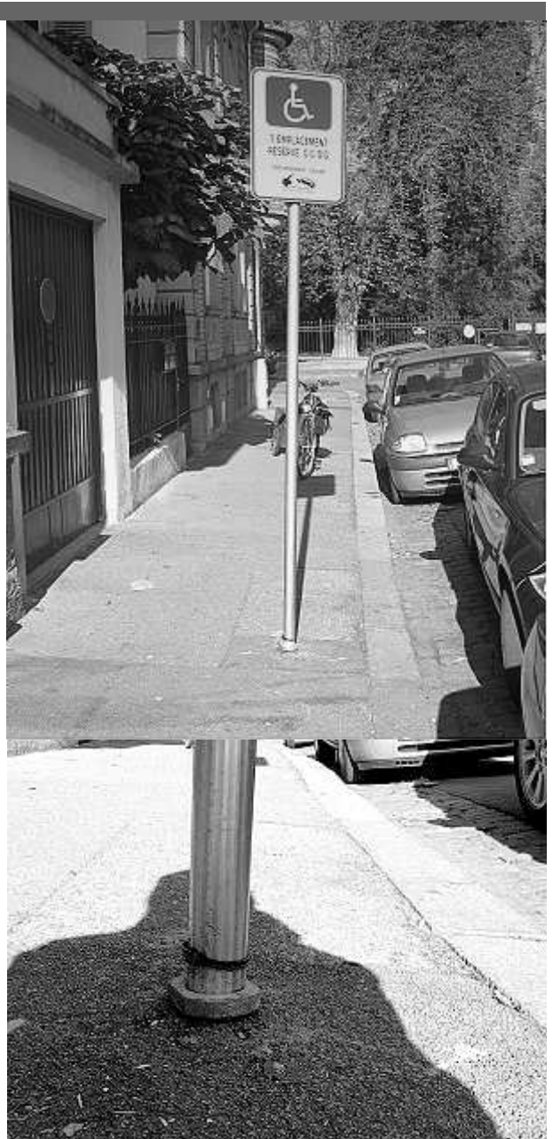
▲ Un poteau mal vissé ou dévissé n'est plus un point fixe !!!
