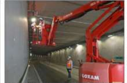
Les travaux de maintenance en cours dans le tunnel sont menés par une équipe de Clemessy. Photos L'Alsace/Derek SZUSTER
