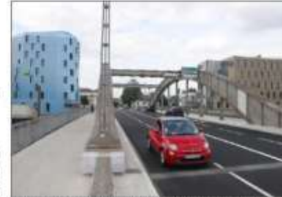
Le pont de Riedisheim est de nouveau ouvert à la circulation. Photos L'Alsace/Derek SZUSTER
