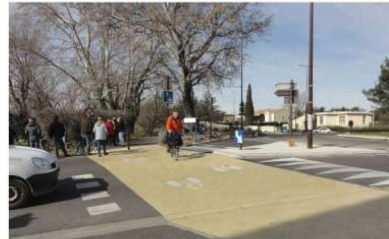
Voie verte rendue prioritaire sur une branche d'un giratoire Source : Cerema
