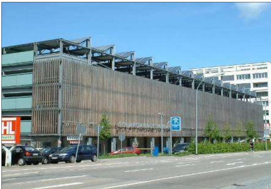
Le « garage solaire » à l'entrée du quartier Vauban, recouvert de panneaux solaires (photo CADR, 2003)
